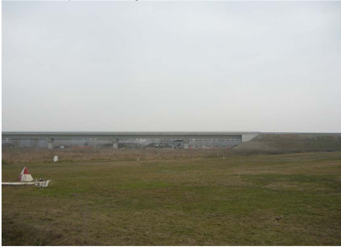
FOTO 1: Nuovo ponte della tangenziale di Piacenza: vista da monte
